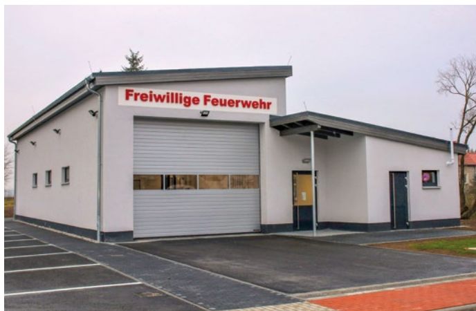
Neues Depot: In Stolzenhain-Hartmannsdorf sind Türen und Holzverkleidung grau.
