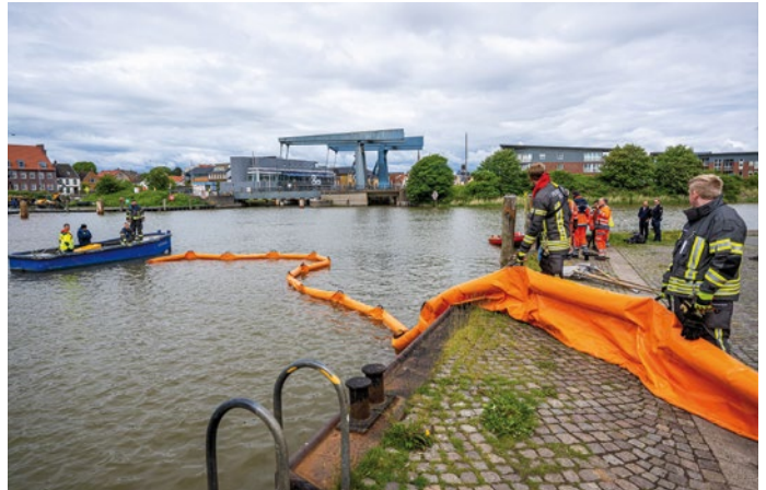
Ölschlängel: Beim Auslegen der Ölsperre half ein Arbeitsboot des LKN (Landesbetrieb für Küstenschutz, Nationalpark und Meeresschutz).
